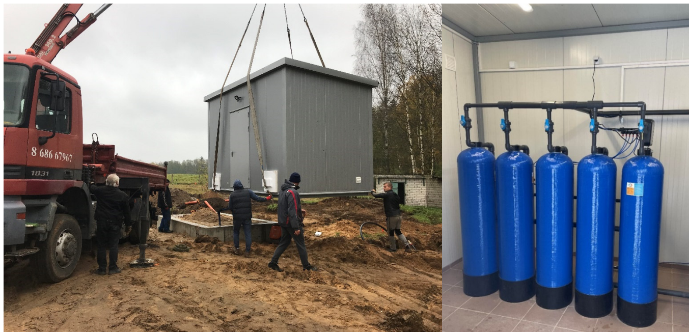
32 pav. Dubičių gyvenvietės vandenvietės vandens gerinimo įrenginių nauja statyba
