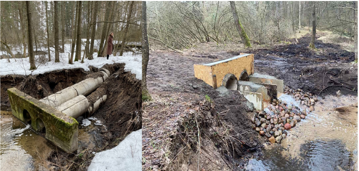
33 pav. Varėnos miesto lietaus nuotekų valymo įrenginių išleistuvas
